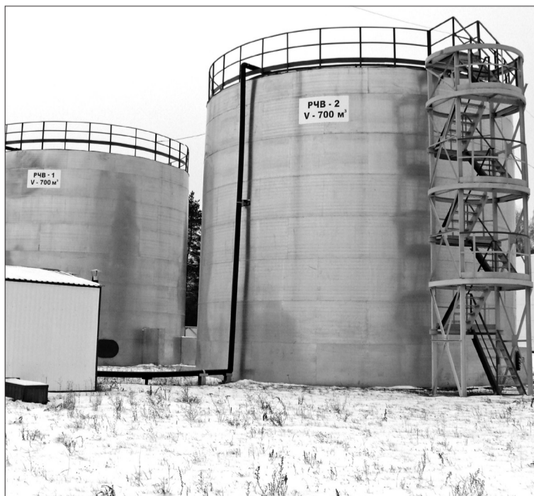
• Водозабор «Новый» с резервуарами чистой воды.
