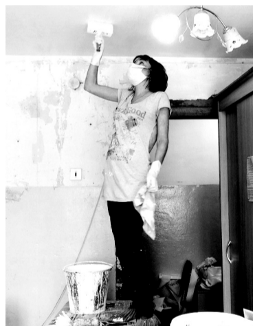
• Ремонт в разгаре.
