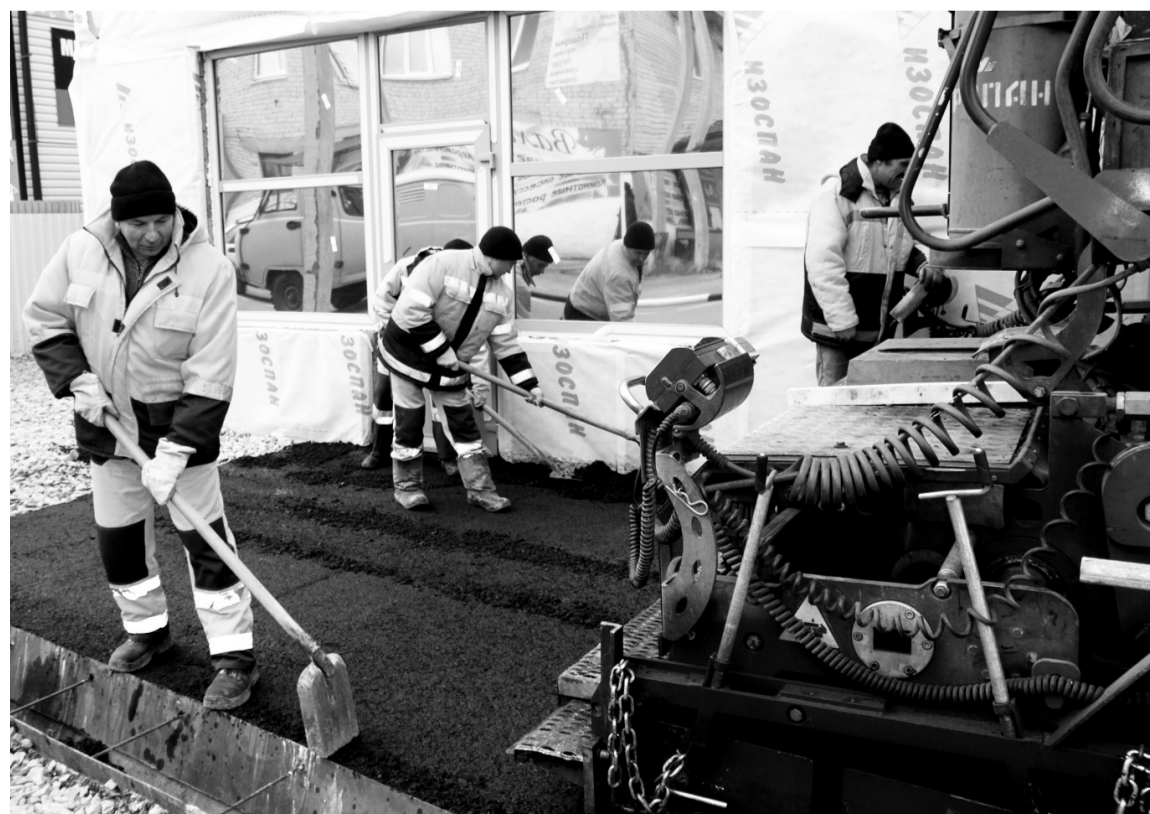
• Бригада дорожников на благоустройстве территории.
